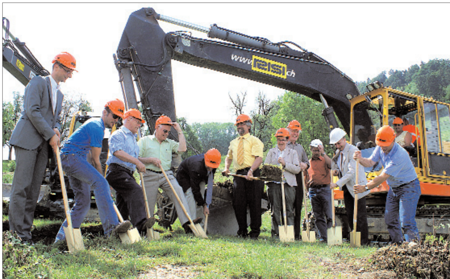
Die Freude war aus den Gesichtern zu lesen, als die von Paul Langenegger (im gelben Hemd) angeführte Baukommission am vergangenen Freitag zum Spatenstich bei der Erweiterung der International School of Zug and Luzern ansetzte. FOTO MWE
